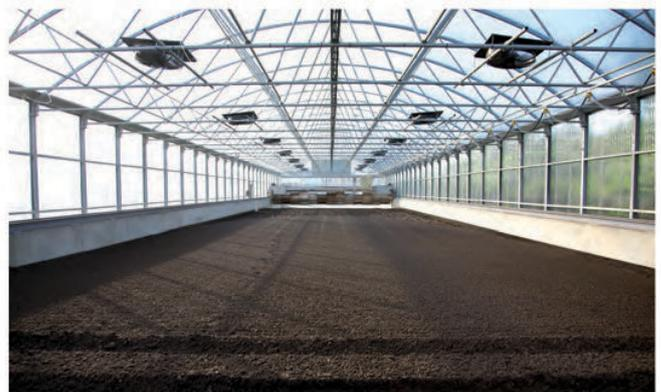
Sécheur solaire des boues (TERSOLAIR)
